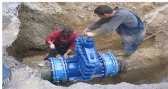
Zëvendësimi i armaturës së ujësjellësit
