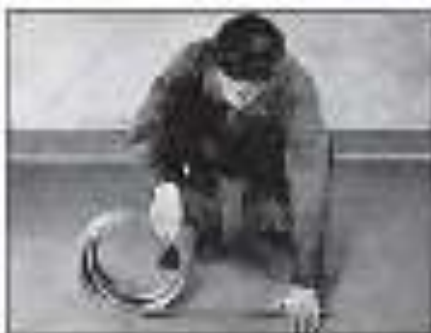
Mbështillja e fijeve të kërpi në tubin e bakrit.
