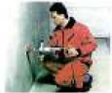
Figura 8.1: Një punëtor që po përdor një vegël elektrike për të hapur një vrimë në mur.
