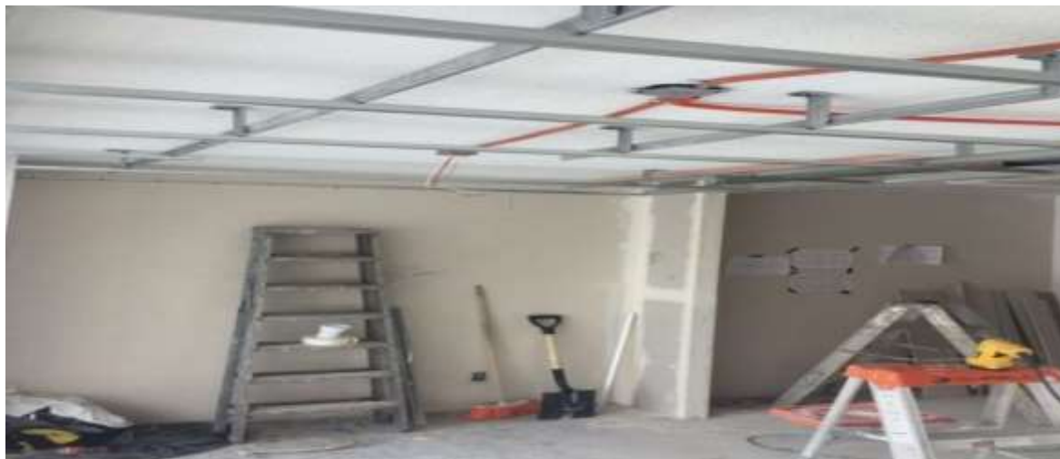
FOTO. 4. JANË INSTALIME ELEKTRIKE TË REALIZUARA NË TAVANE
