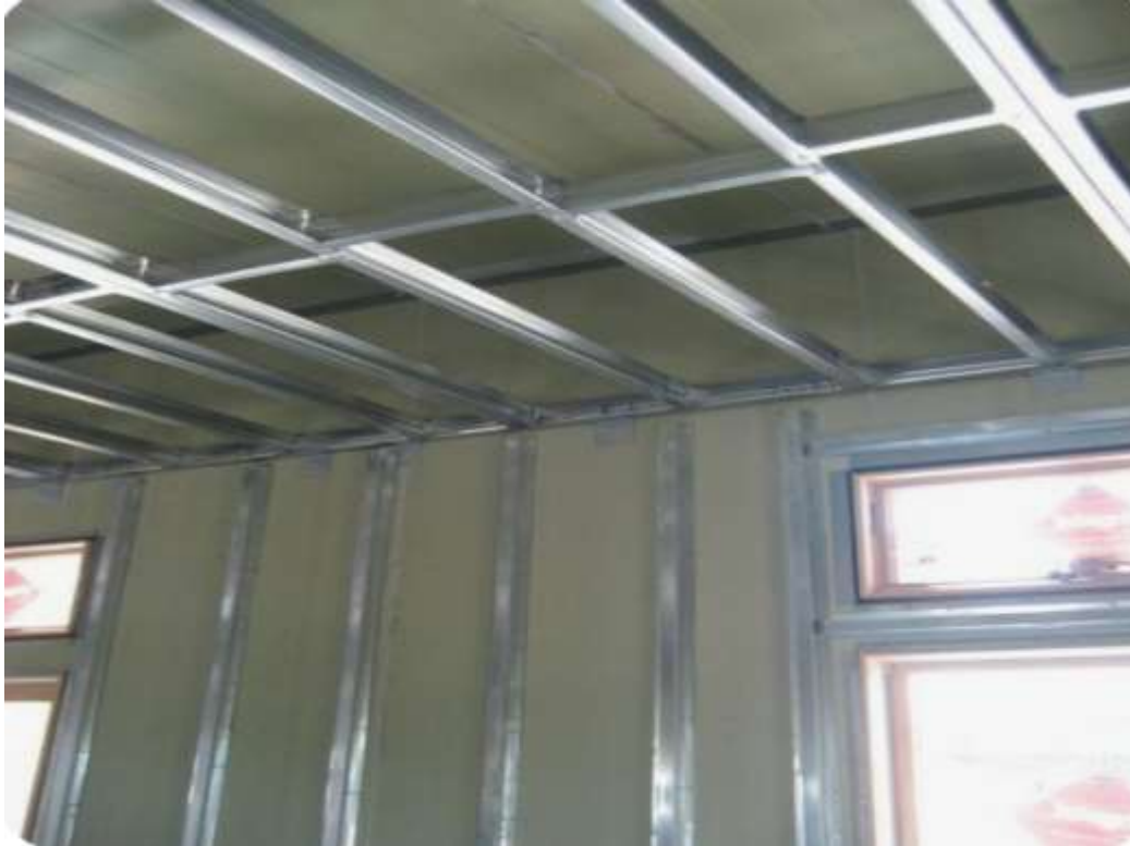
FOTO. 3 PUNIME TË PËRFUNDUARA TË MONTIMIT TË SISTEMEVE METALIKE TË GATSHME PËR MONTIMIN E PLLAKAVE TË GIPSIT
