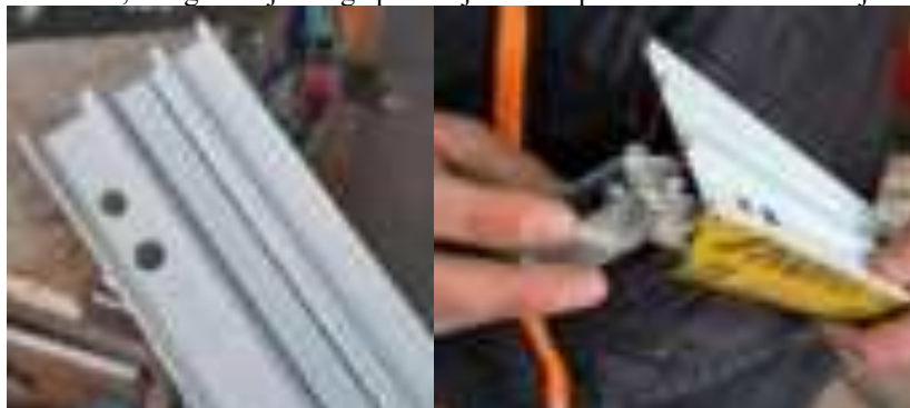
Figura 4.1.2.14. Vrimat në profil alumini janë parashikuar për montimin e fllanxhës (figura e majtë) dhe montimin e fllanxhës në profil alumini (figura e djathtë)
