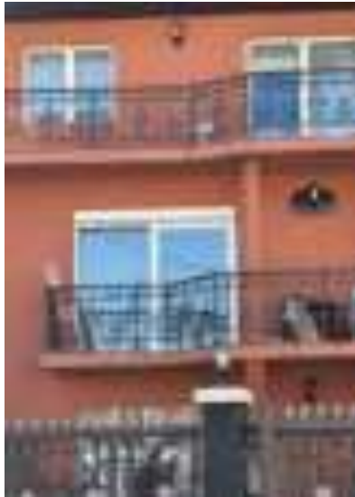
Figura 4.1.3.1. Pamja e produkteve të bëra: Kangjella çeliku, dyer dhe dritare me profil PVC Burimi: Autorë
